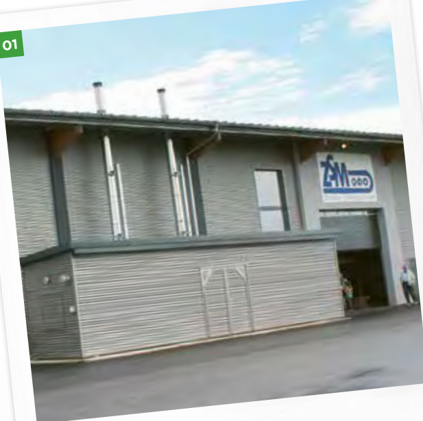
ZSM. EnergyBox van 224 kW. Die façade is in harmonie met het firmagebouw.
